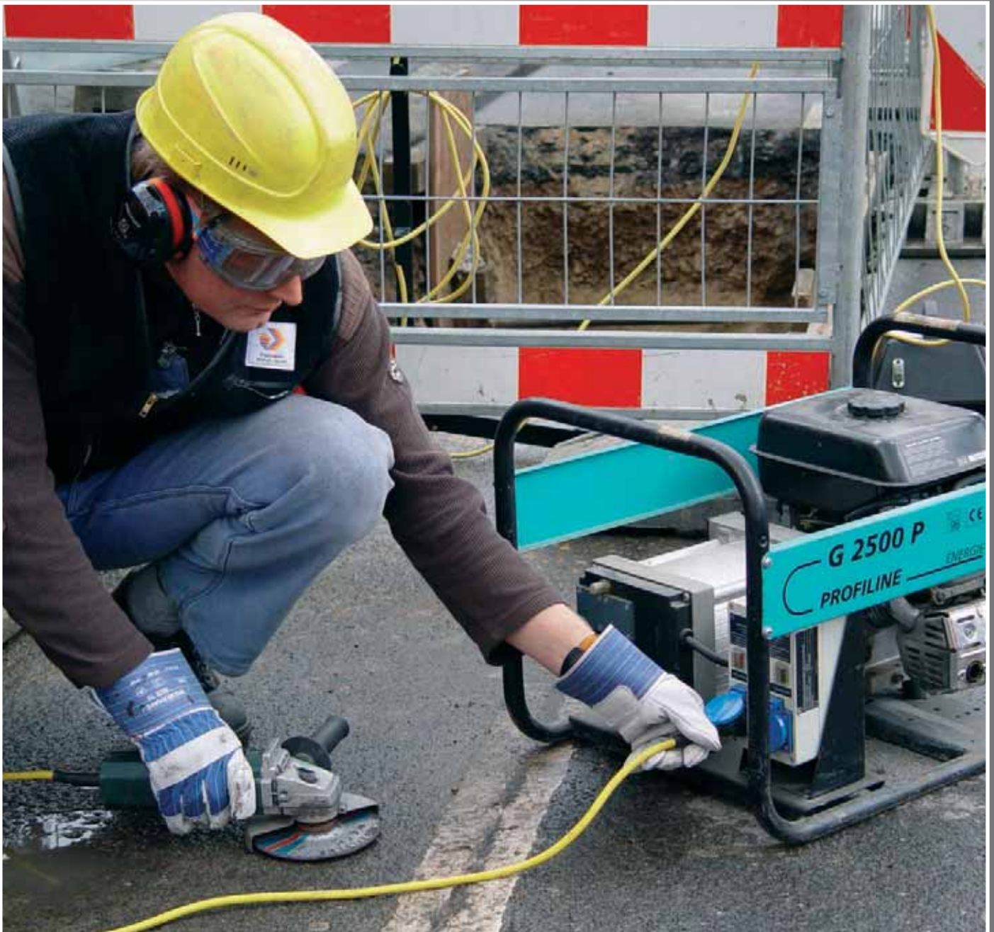
Elektrische Betriebsmittel auf Baustellen
