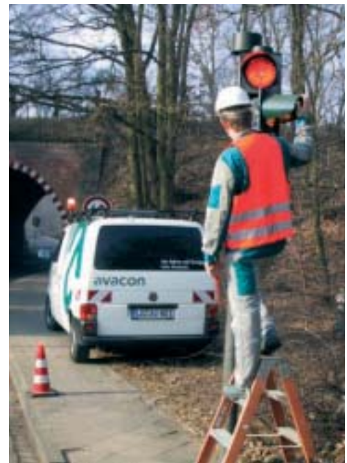
Wechsel der Leuchtmittel an einer Lichtsignalanlage
